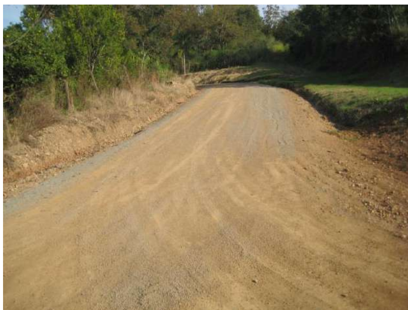
Figura 29 – Drenagem das águas pluviais através de valas escavadas
