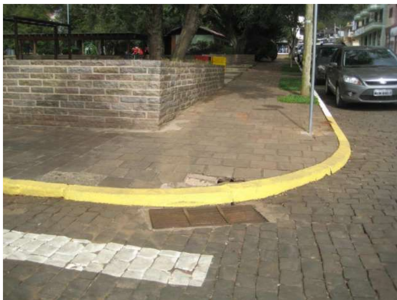
Figura 30 – Bueiro implantado na área central
