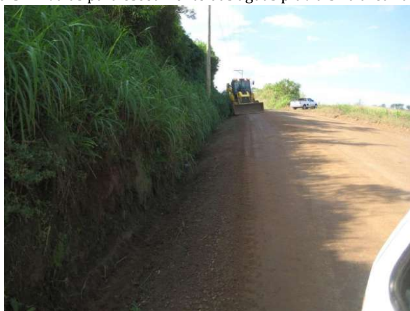
Figura 34 – Valas para escoamento das águas pluviais na área rural
