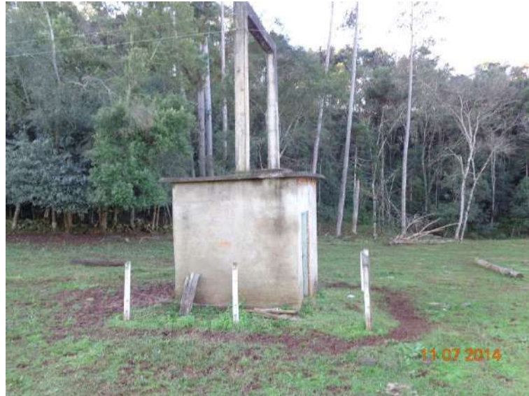
Figura 25 – Poço tubular Botoni
