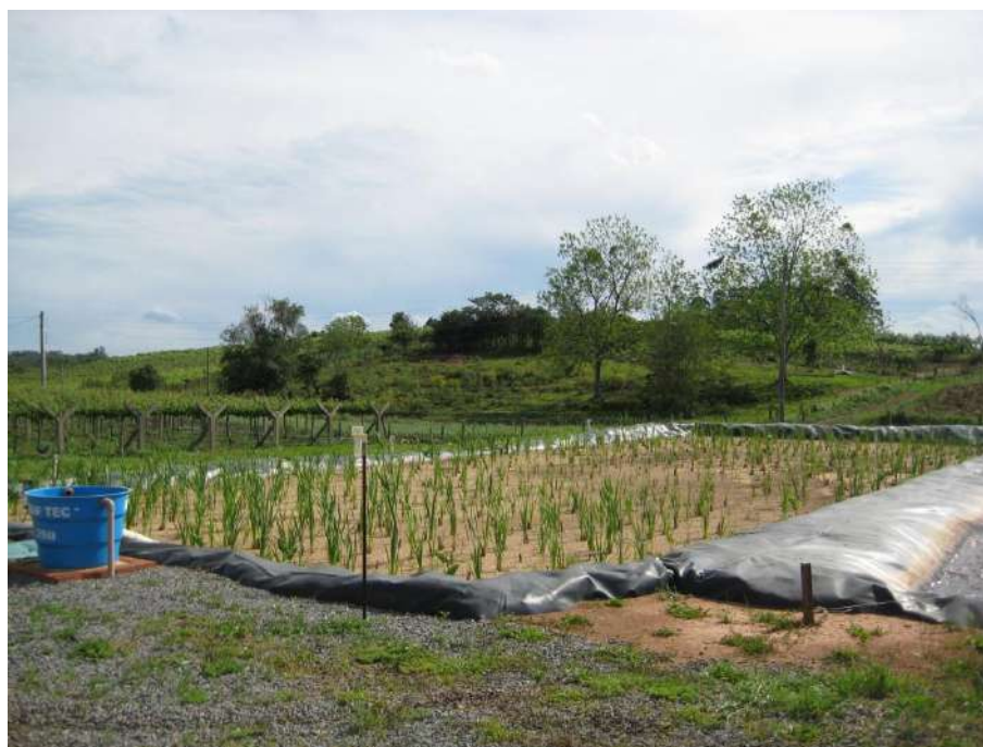
Figura 52 – Sistema wetland em fase inicial de implantação
