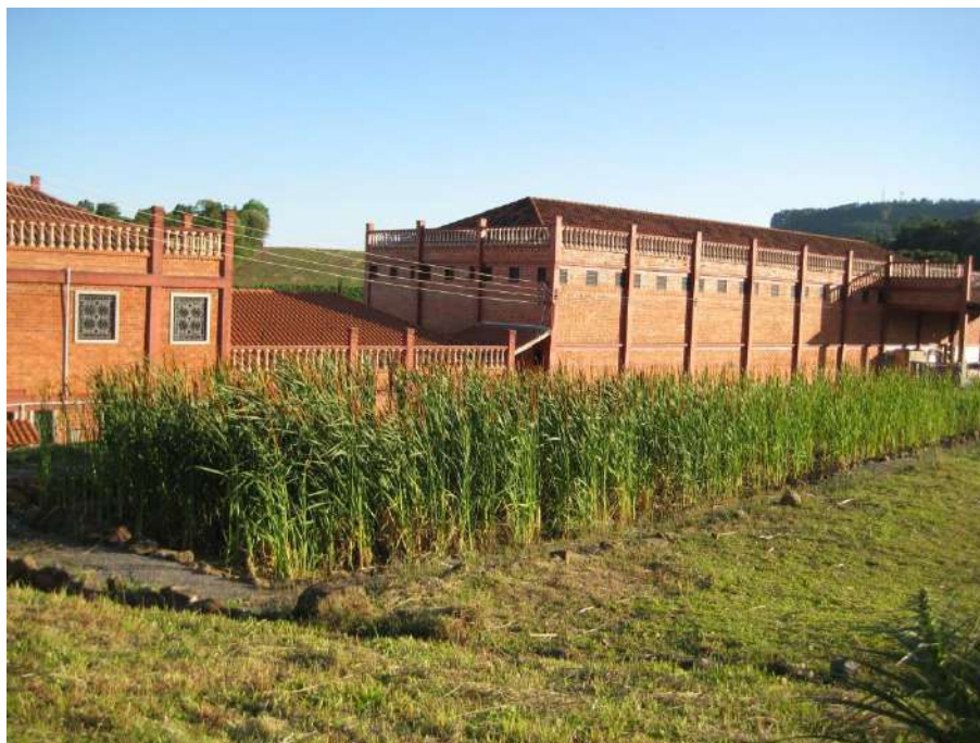
Figura 53 – Sistema wetland em operação plena
