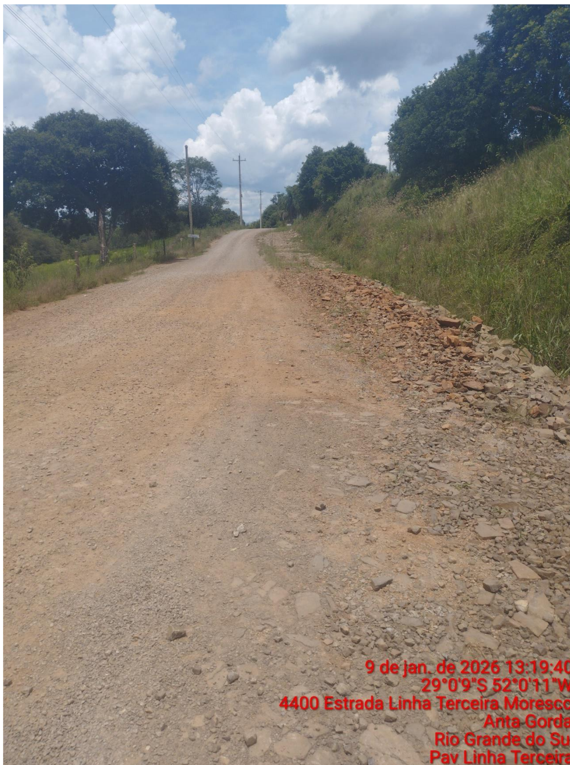
Figura 4 – Imagem do trecho a pavimentar.
