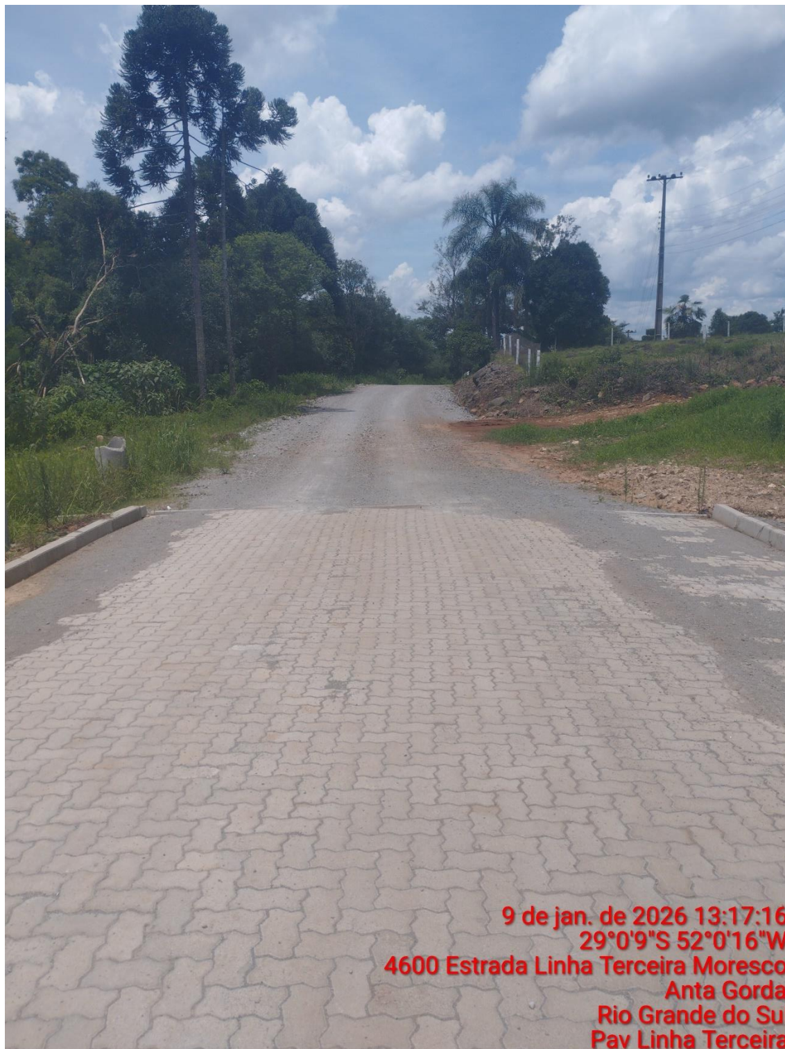
Figura 2 – Imagem do trecho a pavimentar.
