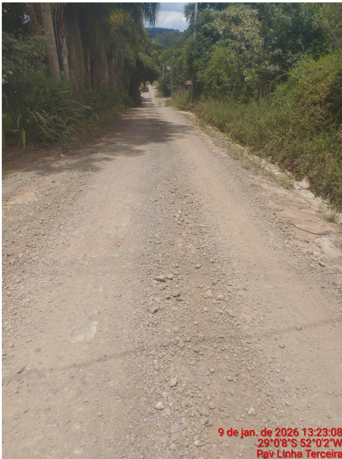
Figura 5 – Imagem do trecho a pavimentar.
