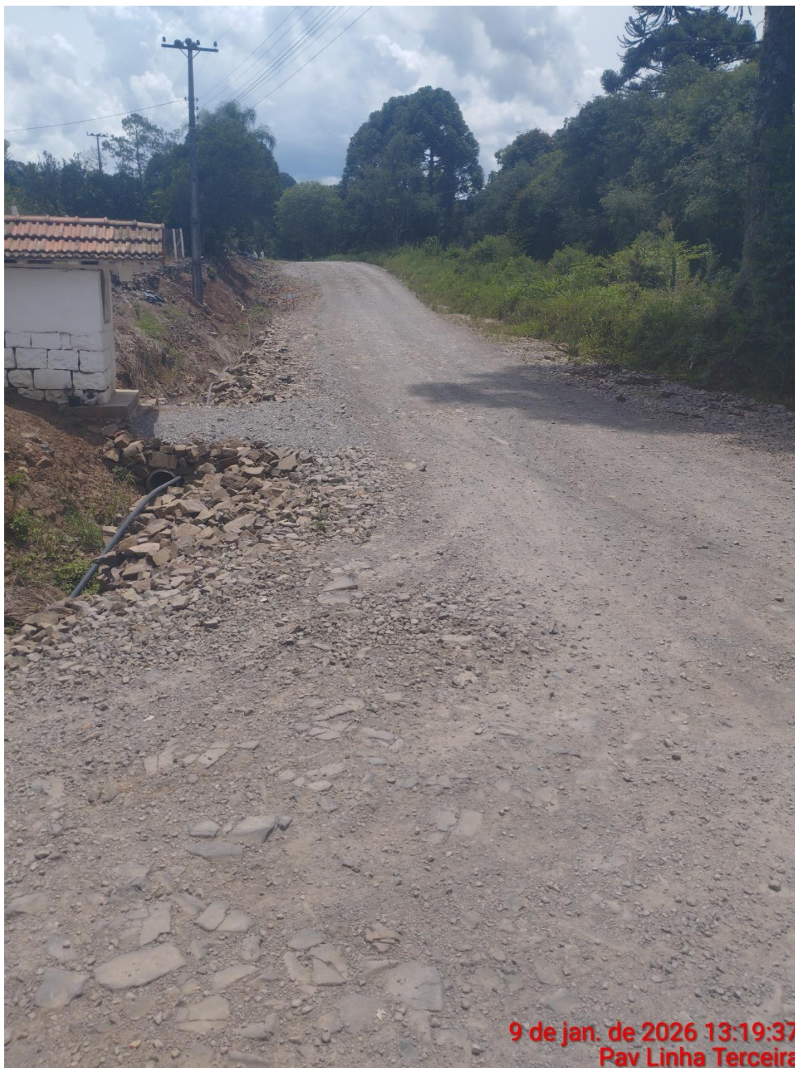
Figura 3 – Imagem do trecho a pavimentar.
